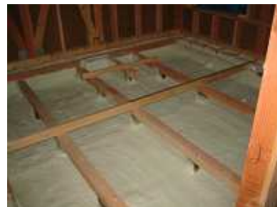
発泡ウレタン施工中の様子
