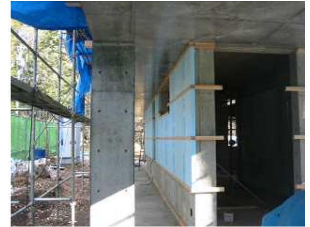
断熱材施工中の様子
