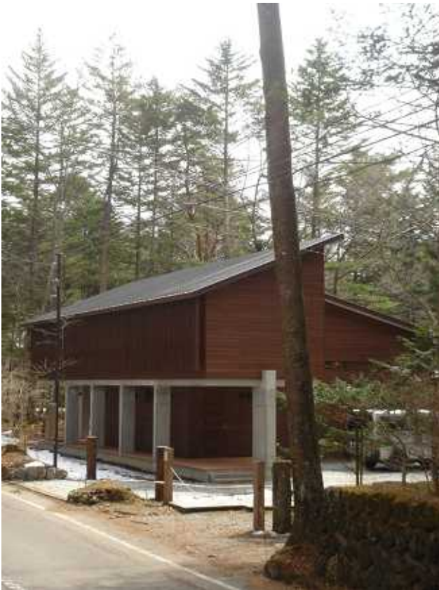
前面道路から見る
