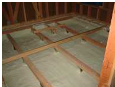
発泡ウレタン施工中の様子
