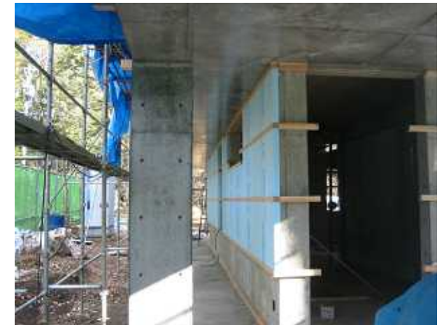
断熱材施工中の様子
