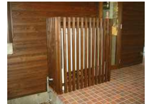
オイルタンクは木製格子で覆った
