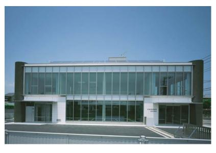
カーテンウォールは異なる材質(RCスラブやRC曲面壁、押出成型セメント板) と取り合うため、各部フラッシング等防水ラインを確保し、意匠的にも役物パネル を使い、特徴あるディティールを表現した。
